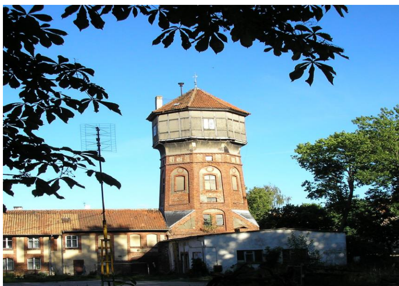
Zdjęcie /2013r/: Wieża Ciśnień w Karolewie. W chwili obecnej po remoncie przeprowadzonym w roku 2014.
